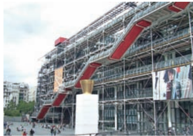
Center Georges Pompidou v Parizu, »arhitekturni King Kong«, čelna fasada s tekočim stopniščem / Foto: Wikipedia
