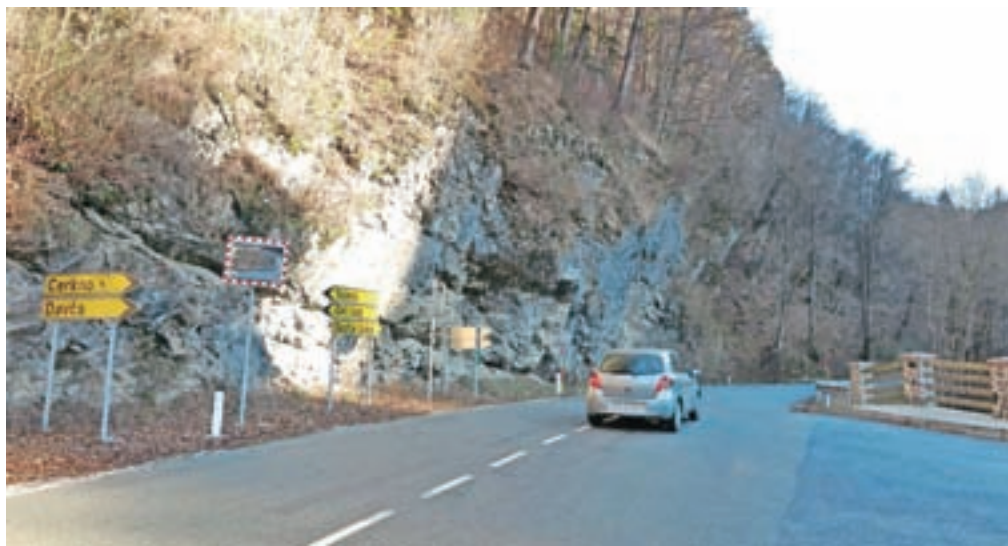
Pri odcepu za Davčo bodo odstranili del skalne brežine in jo zaščitili z visečimi mrežami, poleg tega pa bodo razširili cesto v smeri proti Zalemu Logu. / Foto: Ana Šubic
