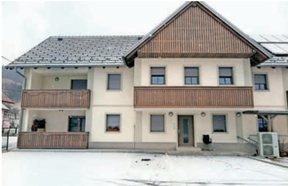
Stanovanjski objekt s petimi neprofitnimi stanovanji na Selu je energetsko varčen in deloma tudi nadstandarden.
