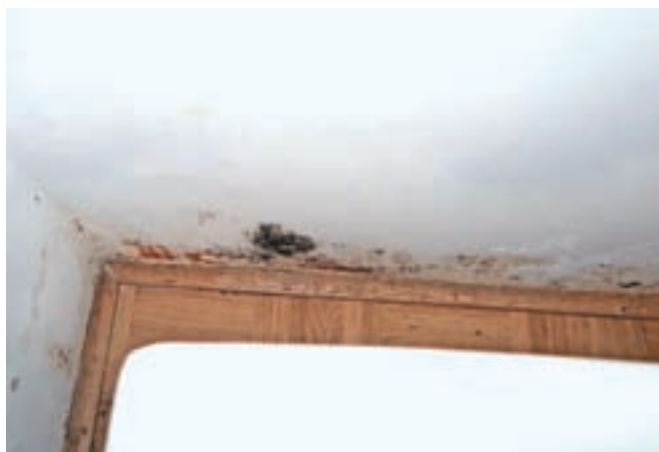
Plesen za kavčem v stanovanju Olge Mlinar: je vzrok slaba gradnja ali preslabo zračenje?
