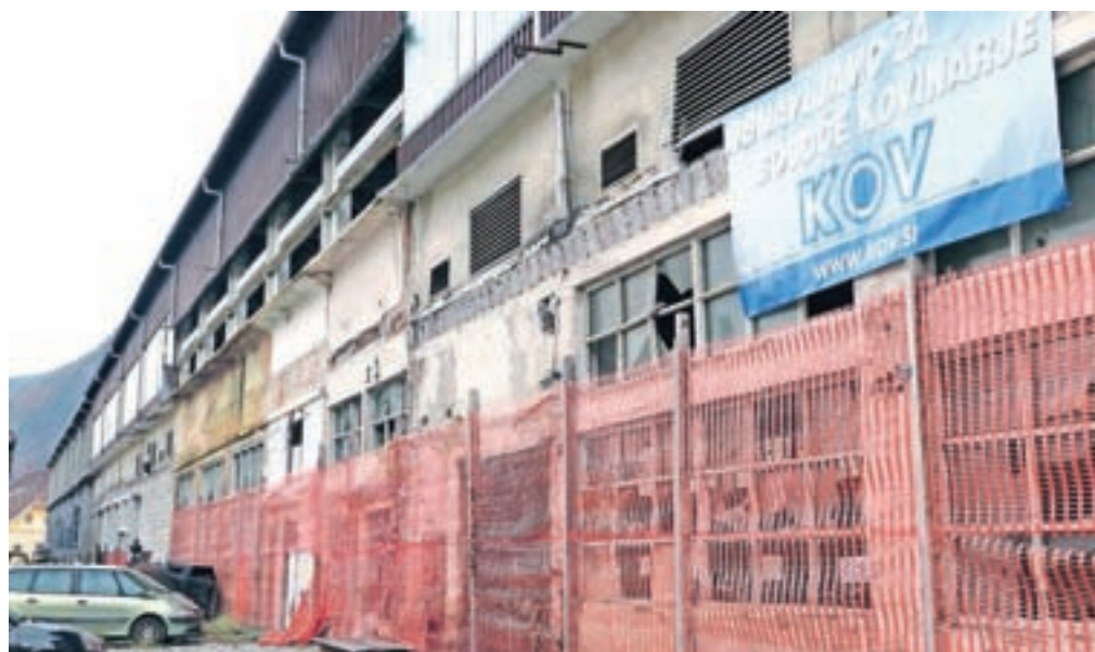
Novi lastnik nekdanje lužilnice je podjetje KOV, objekt pa že obnavljajo.
