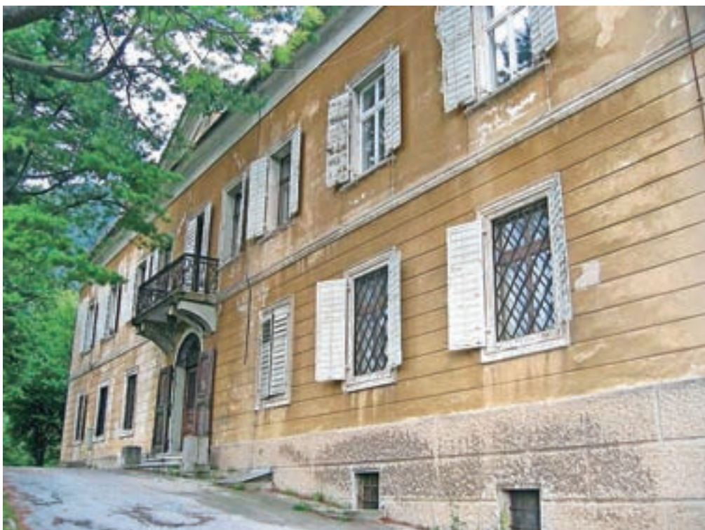
Grad Neuhaus v Tržiču, ki ga je dal po katastrofalnem požaru leta 1811 na novo zgraditi baron Radetzky. / Foto: Wikipedija
