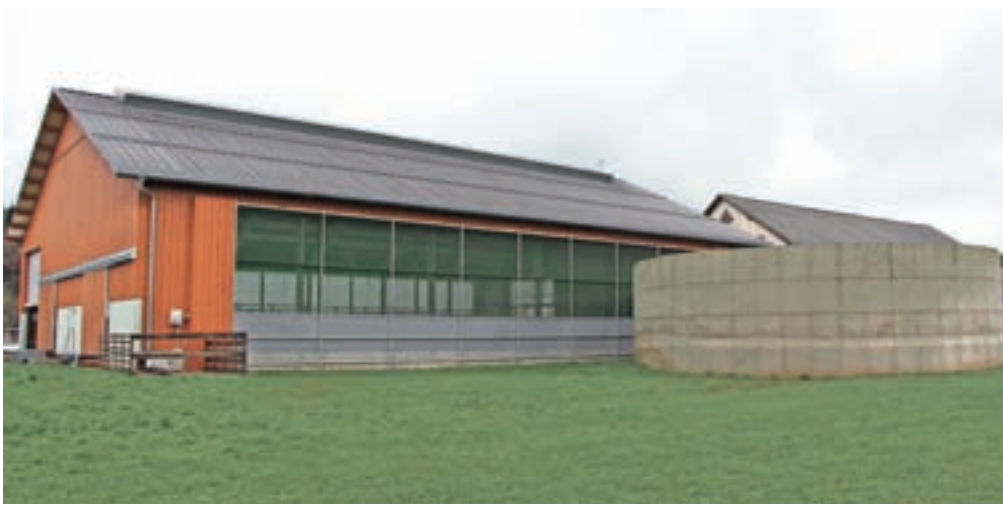
Novi montažni hlev, ob njem jama za 625 kubičnih metrov gnojevke
