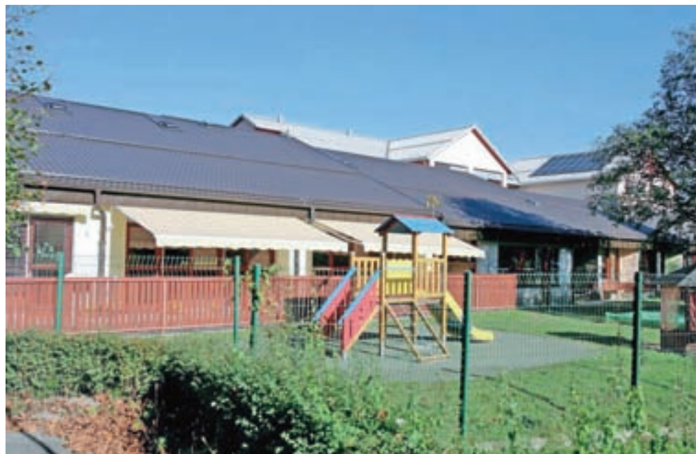
Na vrtcu so poleti zamenjali streho in izvedli energetske sanacije objekta. / Foto: Tina Dokl
