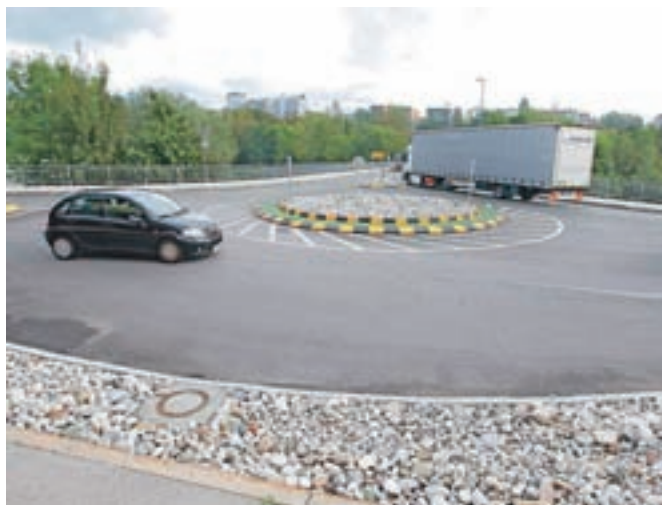
Z novim krožiščem je izboljšana prometna ureditev na območju pri Aquasavi, ki je pripomogla k zmanjšanju zastojev zlasti v času prometnih konic. /Foto: Gorazd Kavčič
