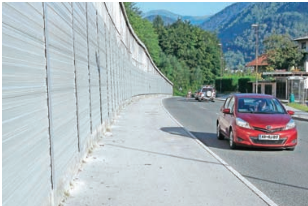
Na betonskem podpornem zidu avtoceste je že nameščena tako imenovana absorpcijska obloga, ki naj bi zmanjšala odboj hrupa. / Foto: Gorazd Kavčič
