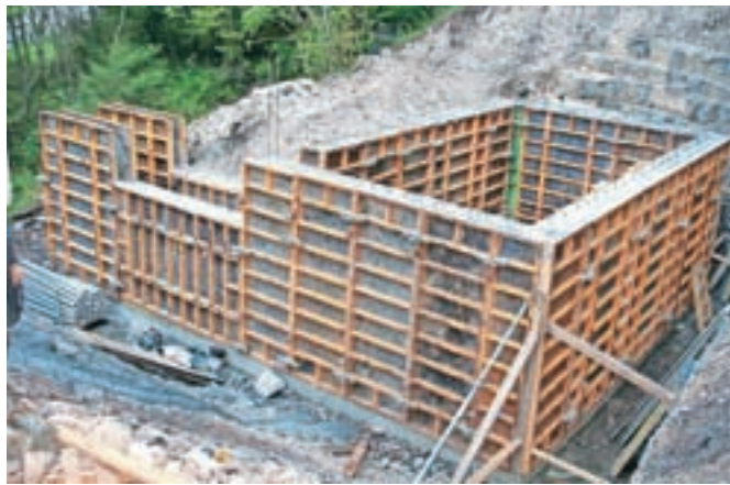
Vodno dovoljenje so pridobili marca 2014, gradnja je prav zdaj v polnem teku.
