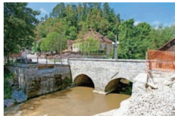
Poleg obstoječega mostu bodo zgradili brv za pešce.
