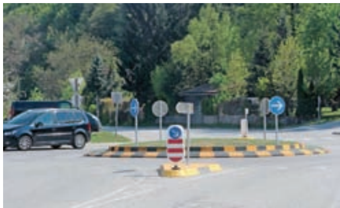
Novo montažno krožišče v zaseku Podreber
