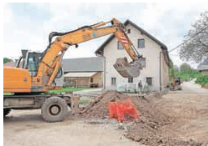
Na trasi gradnje vodovoda Bašelj-Kranj dela potekajo po načrtih in naj bi bila končana do konca junija. / Foto: Gorazd Kavčič
