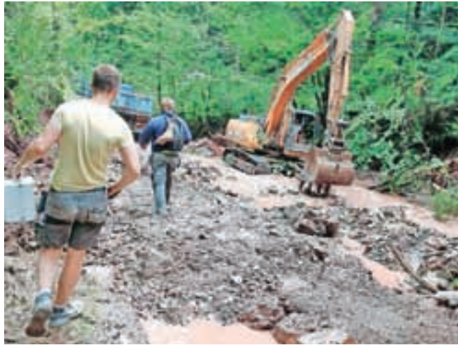
Lokalni izvajalec je sanacijo poškodovane ceste proti Sv. Ožboltu začel že jutro po neurju. / Foto: Gorazd Kavčič
