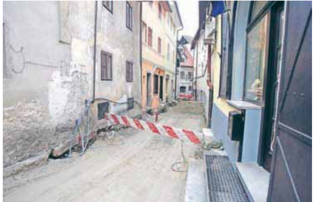
V Škofji Loki nadaljujejo obnovo ulic.
