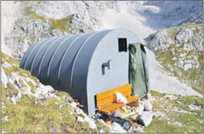
Obnova bivaka je trajala tri mesece, na koncu so popravili še vrata in okna / Foto: Jože Ošlak
