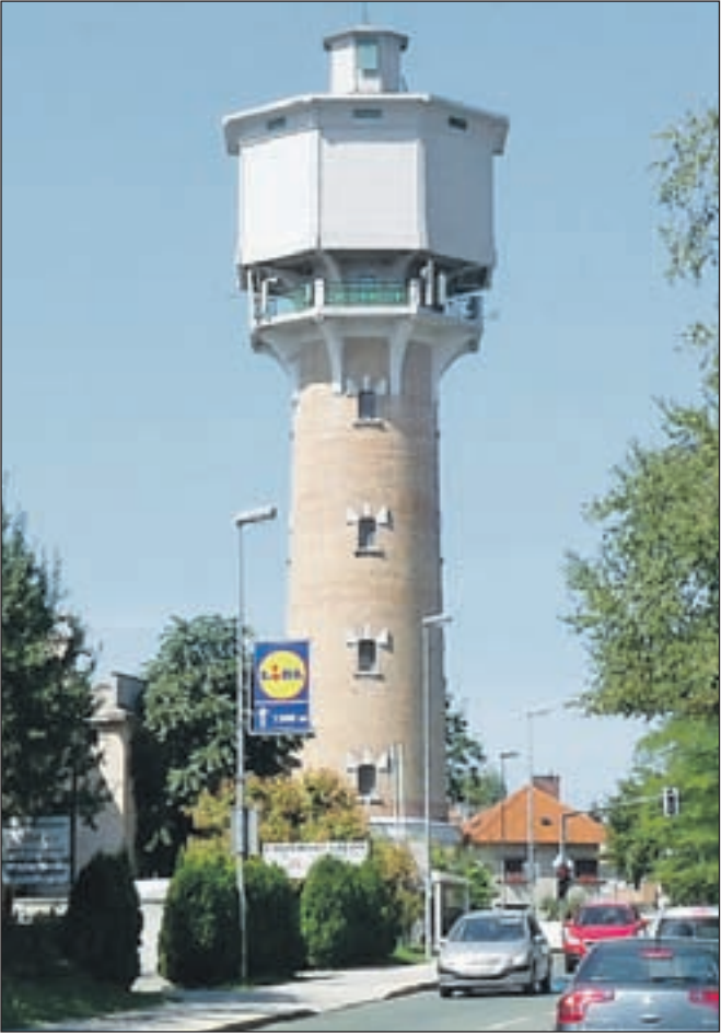
Vodovodni stolp na križišču Oldhamske ceste in Ceste Kokrškega odreda, vpisan v Register nepremične kulturne dediščine; v njegovi bližini se dogaja poglavje Šeligovega romana Triptih Agate Schwarzkobler.
