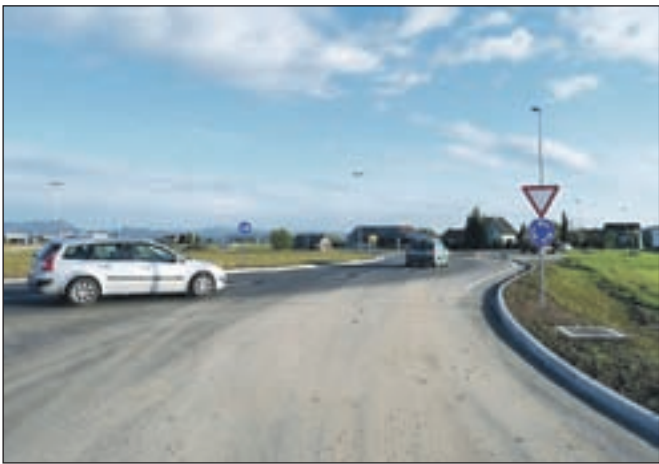
Novozgrajeni del mengeške obvoznice
