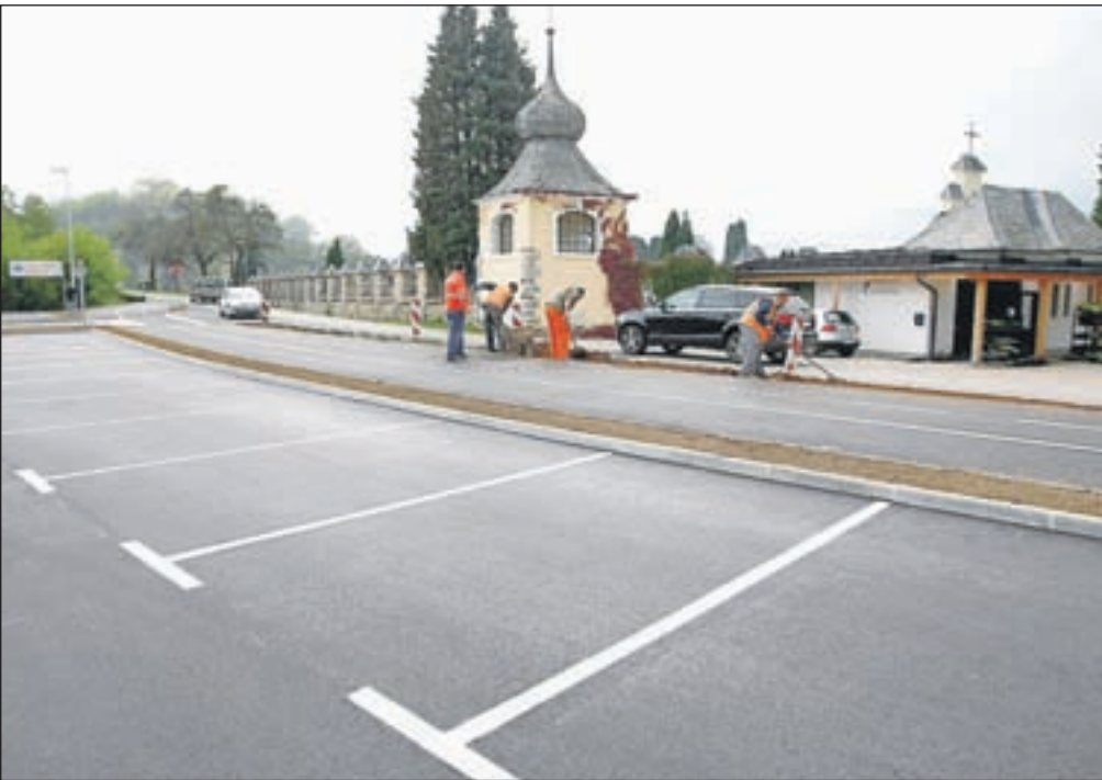
Gradnja parkirišč bo zaključena do 28. oktobra letos. / Foto: Gorazd Kavčič
