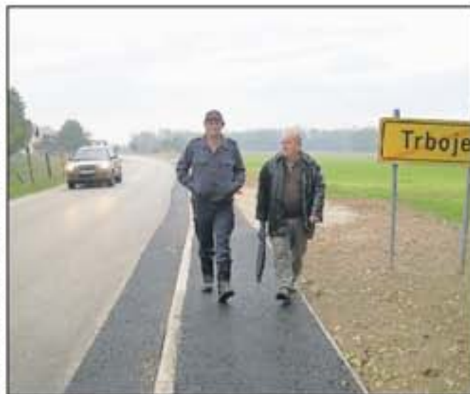
Pločnik med Trbojami in Žerjavko je začasen, saj ga bodo ob gradnji kanalizacije morali zgraditi na novo.
