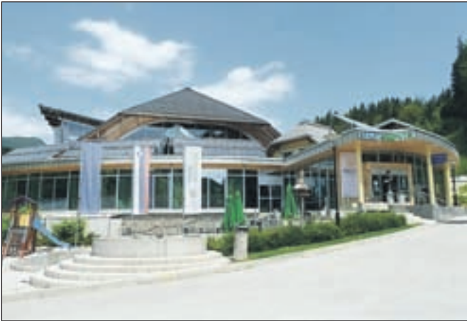
Sončne celice na strehi restavracije zbirajo energijo za ogrevanje bazenske vode.
