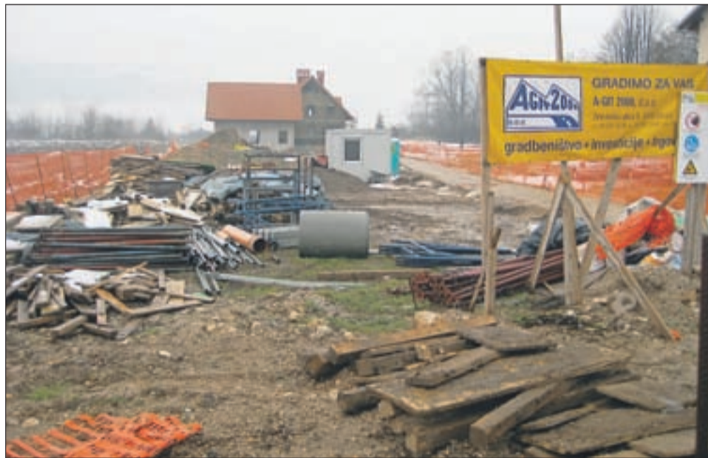
Dela pri gradnji nove hiše za Vovkove že mesec dni stojijo, družina še vedno živi tik ob letališki stezi. Letališče ima začasno uporabno dovoljenje, če želi stalnega, tam Vovkove hiše ne more biti več.
