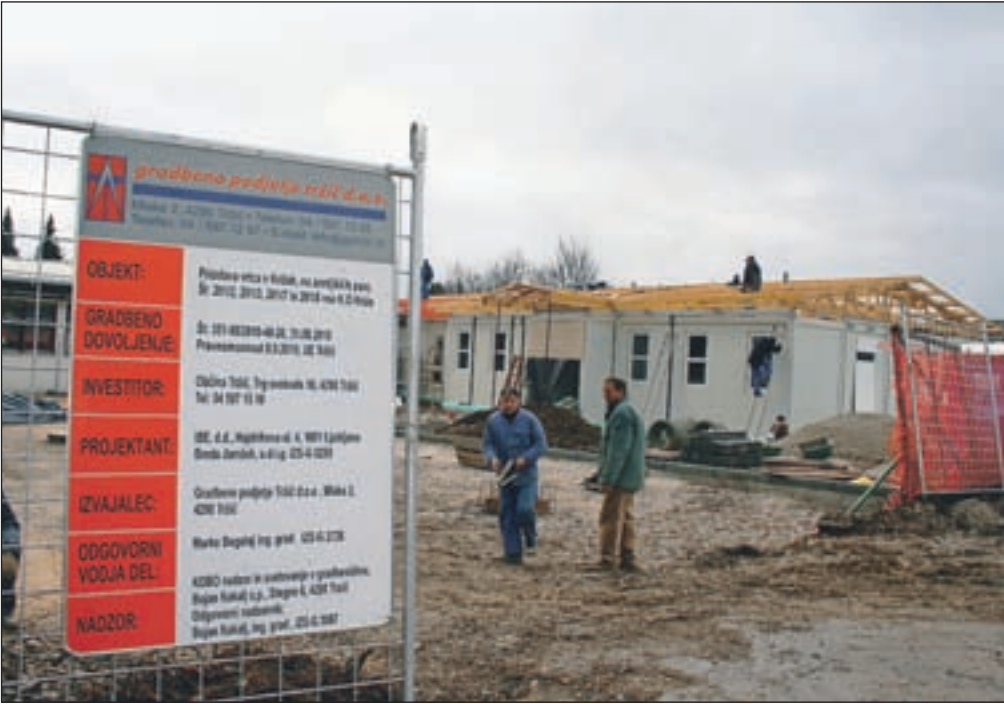
Tržiški gradbinci hitijo z dograditvijo prizidka k vrtcu Križe.
