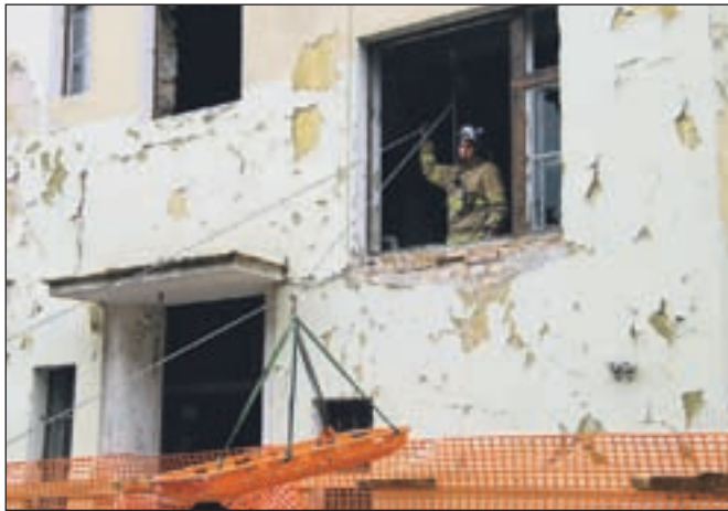
Kranjski gasilci med reševalno vajo iz delno porušene stavbe hotela Jelen / Foto: GRS Kranj
