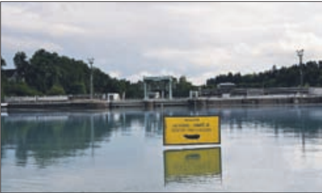
Glavna zapora pred izlivom jezerske vode v turbine
