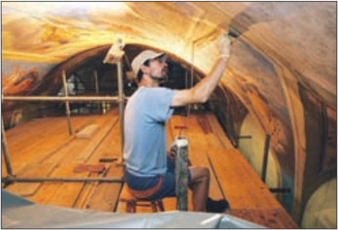
Med obnovo cerkve v Kropi Foto: Anka Bulovec
