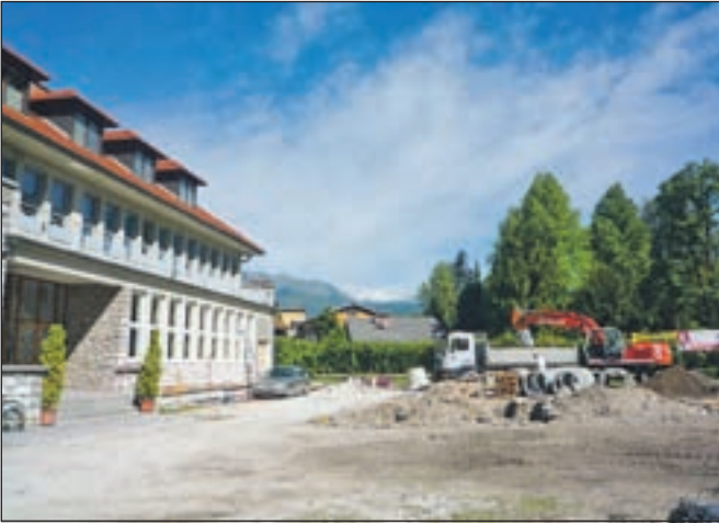
Gradbišče ob OŠ 27. julij, kjer bo stala montažna stavba s petimi oddelki vrtca.
