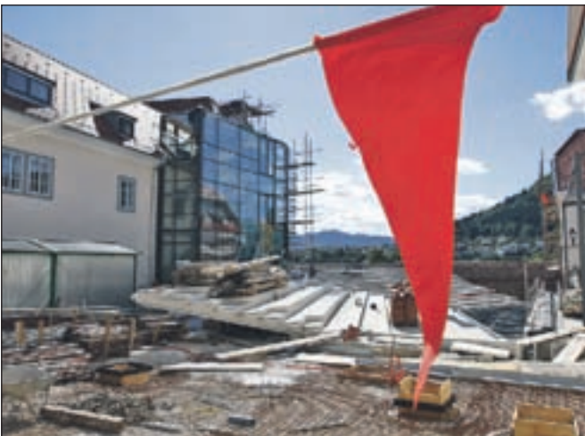
Ali bodo investitorji Vegradu pokazali rdečo zastavo in delo zaupali (in plačali) neposredno podizvajalcem? / Foto: Gorazd Kavčič
