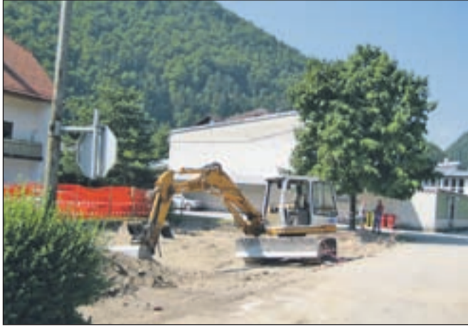
Pri šoli v Železnikih bodo zgradili dodatnih 38 parkirnih mest.
