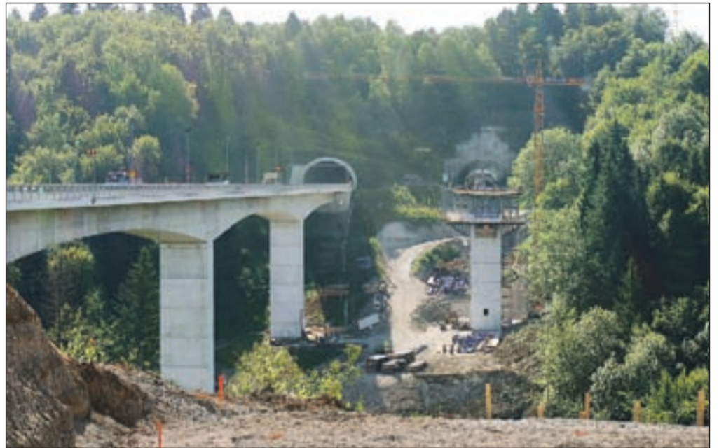
Avtocestni odsek Peračica-Podtabor bo zadnji zgrajeni avtocestni odsek v Sloveniji po nacionalnem avtocestnem programu. Dograjen bo čez leto dni. / Foto: Tina Dokl
