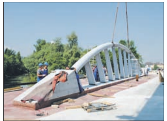
Nameščanje enega od obeh jeklenih lokov, ki bosta zaznamovala most prek Kamniške Bistrice.
