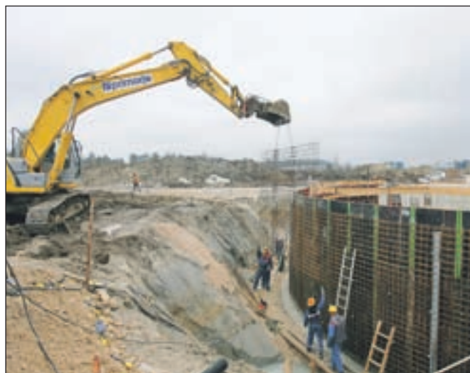
Na gradbišču poslovne cone v Komendi / Foto: Tina Dokl
