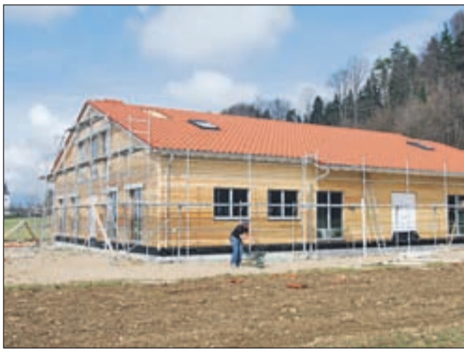
Delavnice so pod streho, dela bodo potekala še celo leto, odprtje pa načrtujejo za prihodnjo pomlad.
