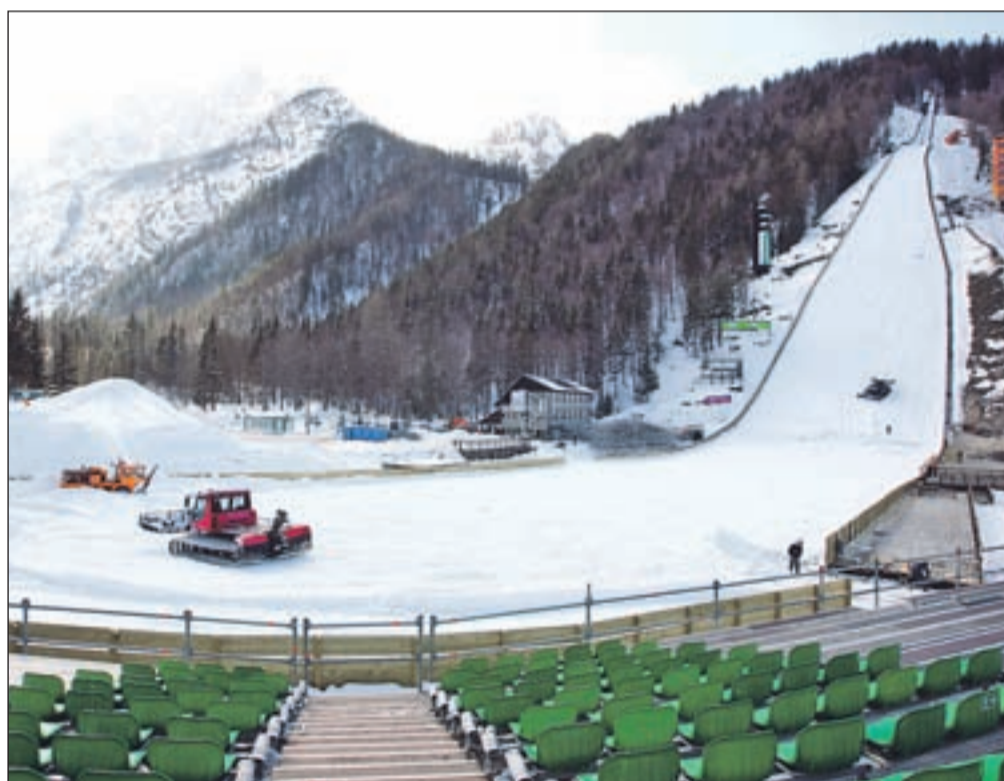
Planiški delavci te dni urejajo še zadnje podrobnosti v izteku posodobljene letalnice, ki naj bi jutri ob 11. uri pričakala prvi preizkus. / Foto: Anka Bulovec
