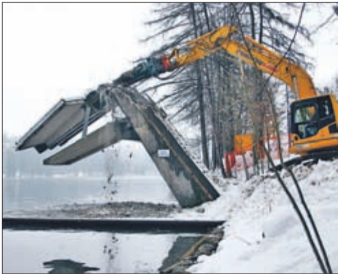
Včeraj so v okviru celovite prenove veslaškega centra porušili sodniški stolp ob Blejskem jezeru. / Foto: Gorazd Kavčič
