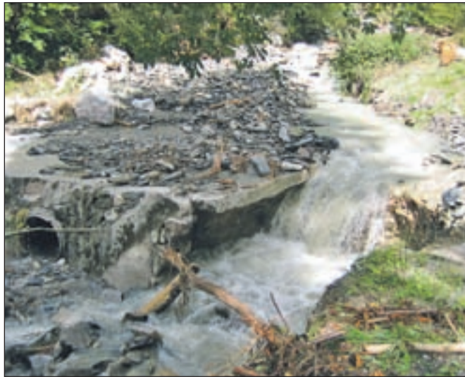
Poškodovana gozdna cesta Dašnica-Hribi
