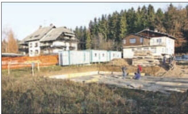
Začetek gradnje zdravstvenega doma v Preddvoru
