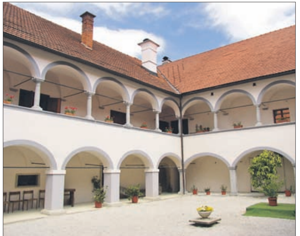
Grad Tuštanj se že vrsto let postopoma obnavlja pod budnim očesom konzervatorjev s Kranjskega zavoda za varstvo kulturne dediščine.
