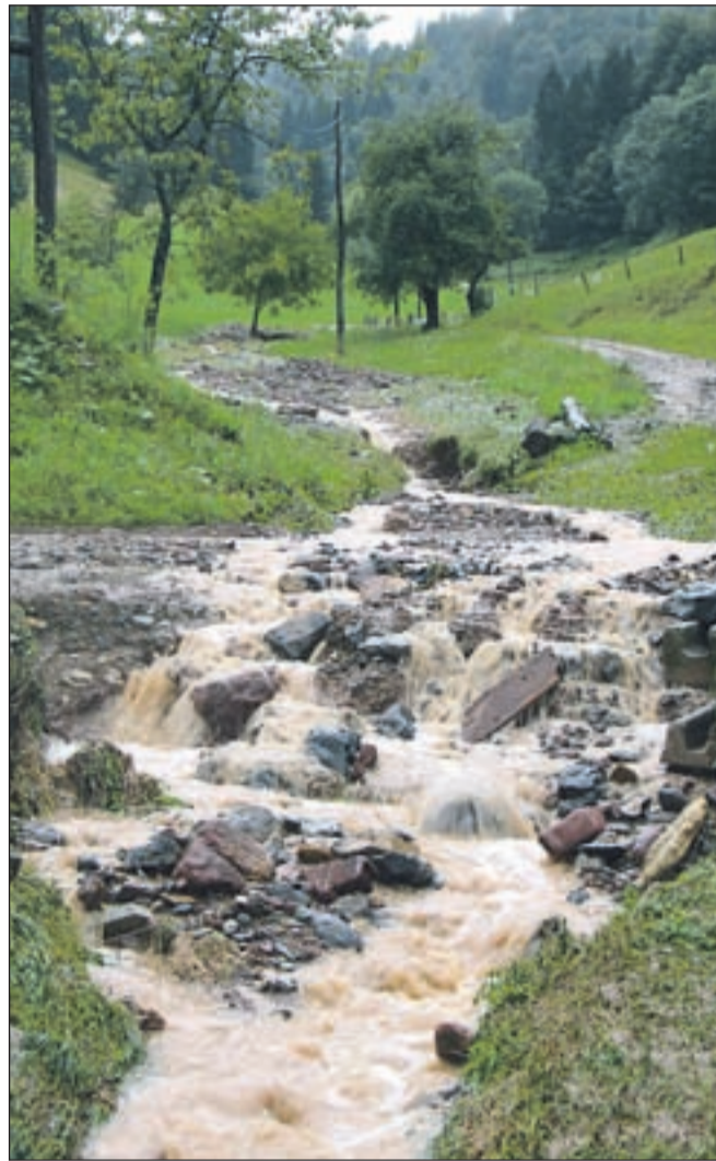
Neurje je krepko poškodovalo tudi makadamsko cesto v Jarčji dolini, za katero domačini od občine Žiri že vrsto let zamašajo asfalt.
