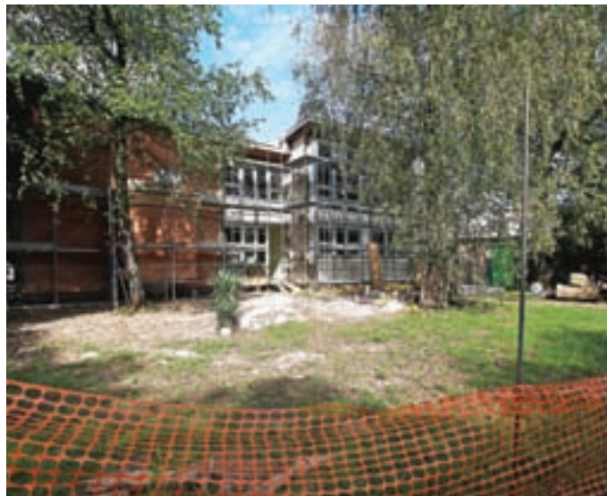
Projekt prenove za dodatne prostore OŠ Jakoba Aljaža Kranj naj bi bil v celoti zaključen jeseni 2025. / Foto: Gorazd Kavčič
