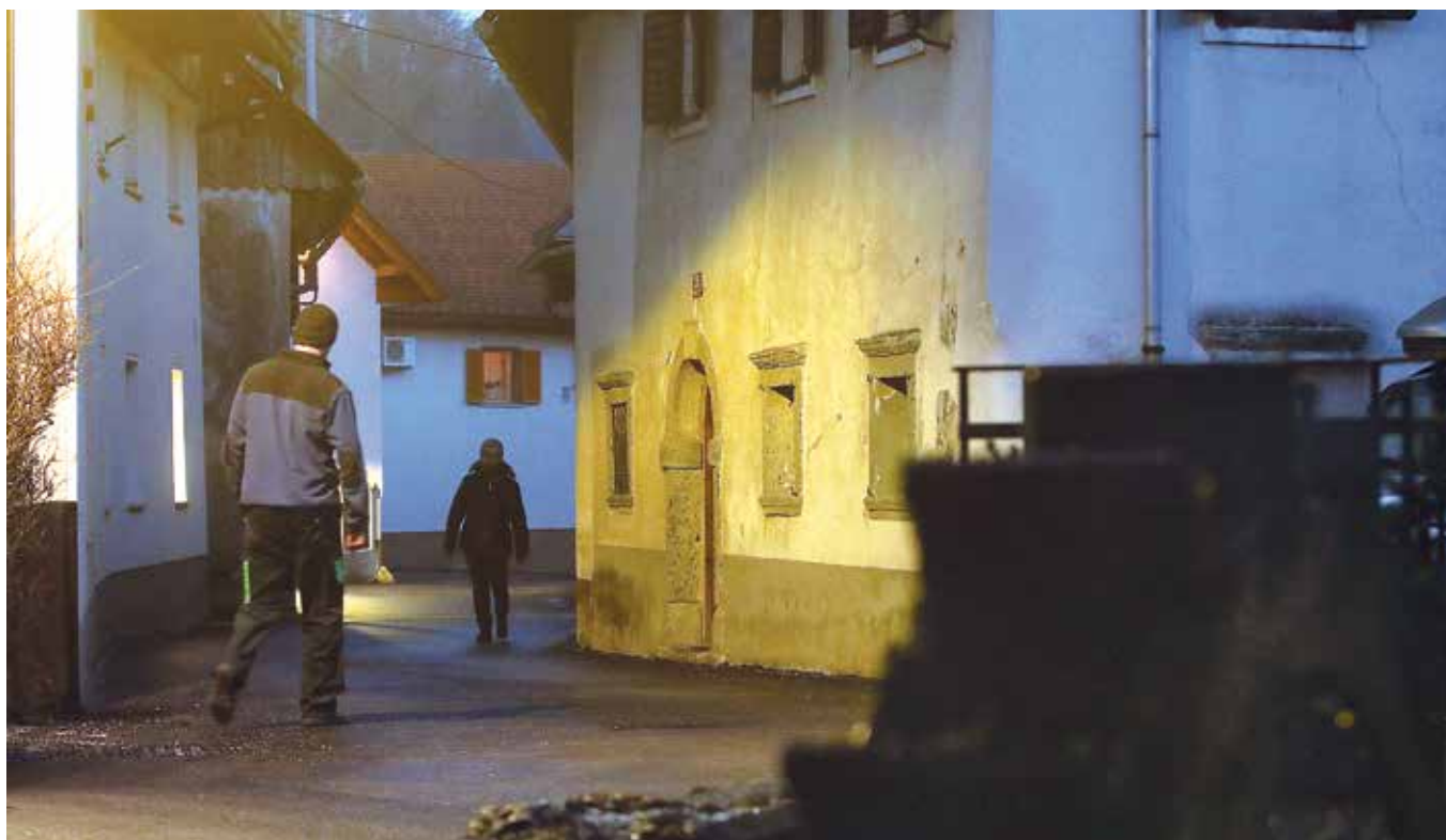
V Kamni Gorici so zaključili prvo fazo projekta izgradnje komunalne infrastrukture. / FOTO: GORAZD KAVČIČ
