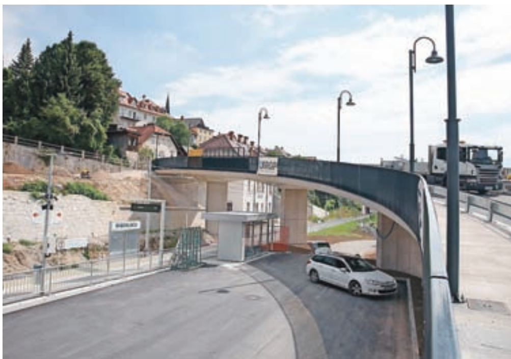
Potniški peron na železniškem postajališču v Radovljici je prestavljen na južno stran proge, stopniščni objekt na severni strani pa je bil odstranjen. Ob novem južnem peronu se v sklopu nadgradnje železniške proge zaključuje gradnja parkirišča P&R (parkiraj in se odpelji). / FOTO: GORAZD KAVČIČ
