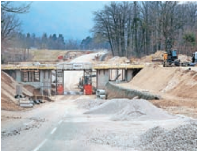
Popolne zapore regionalne ceste v Lipniško dolino pod železnico v Lescah ni več, do sredine junija je na tem odseku predvidena le še delna zapora. Dela bodo potekala v dveh fazah, kar pomeni izmenično zaporo leve in desne polovice vozišča. / FOTO: GORAZD KAVČIČ
