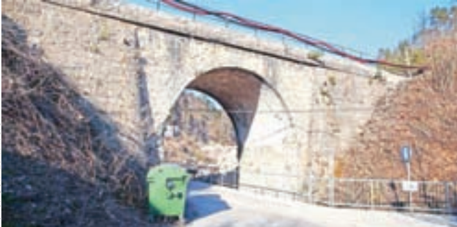
Cesta v Globokem bo zaradi sanacija obokov podvoza pod železnico predvidoma zaprta do sredine aprila
