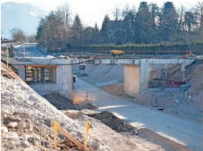
Ob podvozu pod progo na regionalni cesti v Lipniško dolino sta že zgrajena dva preboja pod železnico, namenjena ureditvi kolesarske povezave in pločnika.
