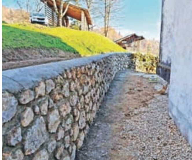
Tokratna obnova drenažnega sistema pri cerkvi je namenjena omejitvi kvarnega vpliva podtalnice in vlaženja severne stene cerkvene stavbe.
