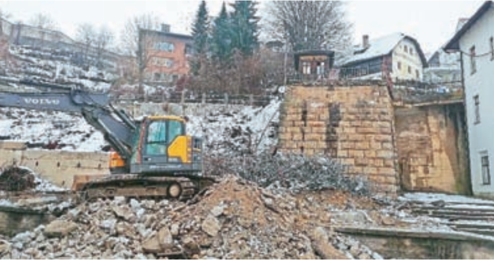
Stari most nad železniško postajo v Radovljici so v začetku meseca podrli. Dostop do pokopališča je urejen čez Linhartov trg, ki je v času do izgradnje novega mostu odprt za promet.
