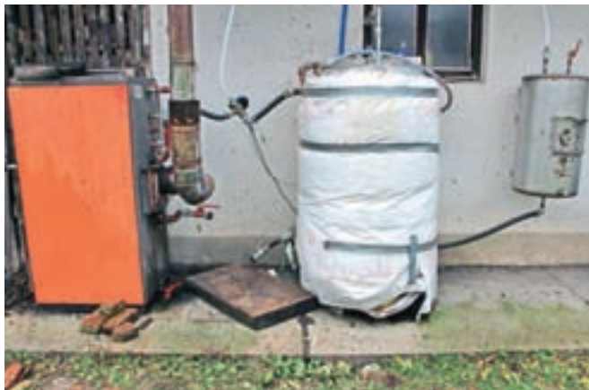
Anže je s pomočjo prijatelja izdelal pasterizator na drva.
