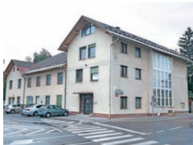
Stavba nekdanjega TVD Partizan v središču Radovljice je že nekaj let v klavrnem stanju. / FOTO: GORAZD KAVČIČ
