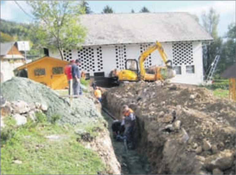
Izkop in polaganje vodovodne cevi
