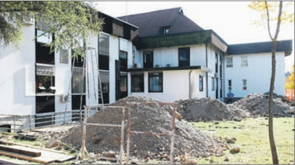
Energetska sanacija radovljiškega zdravstvenega doma se je že začela. / Foto: Gorazd Kavčič
