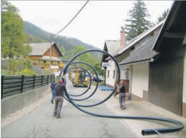
Razvijanje kolutov vodovodnih cevi
