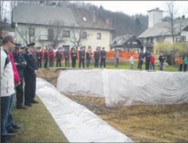
V začetku aprila so v Mošnjah položili temeljni kamen za nov gasilski dom.
