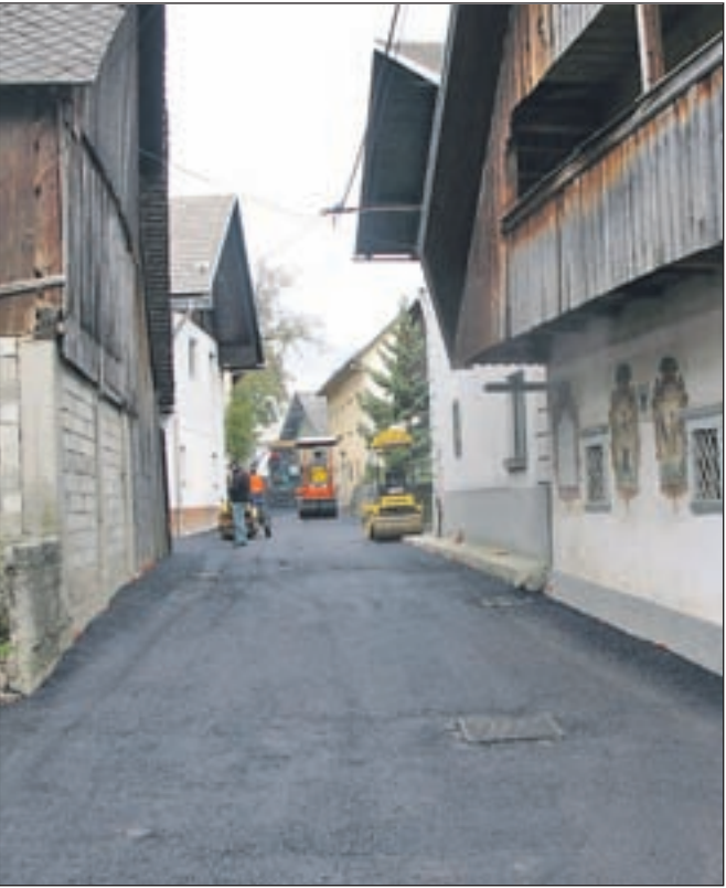
V zadnjem času so v Ljubnem zaključili obsežna dela na krajevni infrastrukturi.
