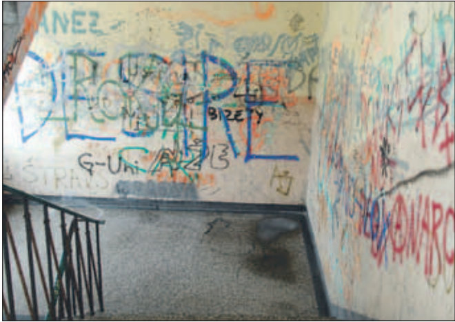
Zanemarjena železniška postaja v Radovljici / FOTO: CVETO ZAPLOTNIK
