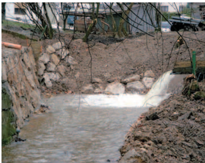
Gradnja nove škarpe na lokaciji Predoslje 120
