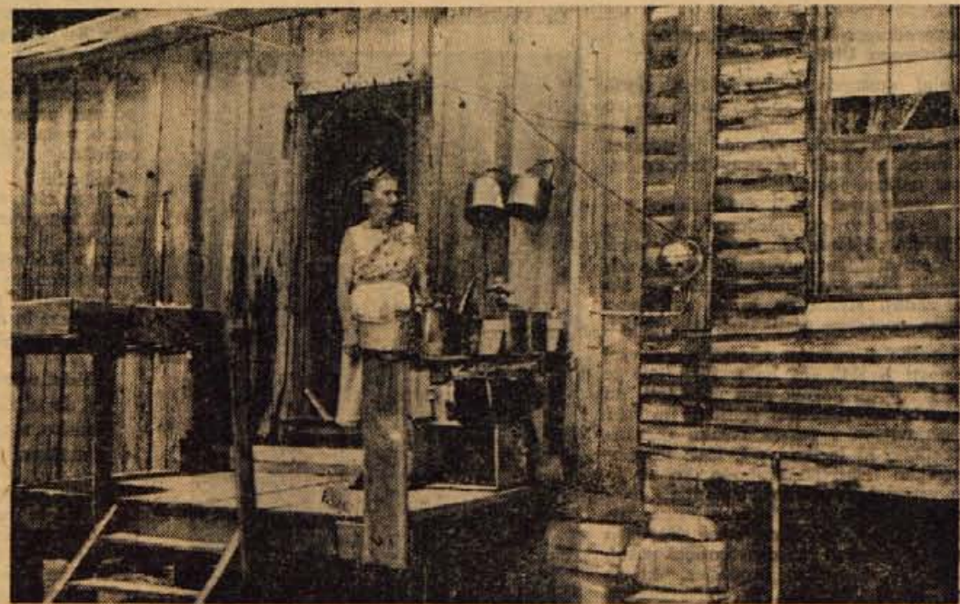
Lesena hiša brezposelnih. Veranda je trhla, streha je le zasilno popravljena. Oddelki za skrbstvo pa varujejo ljudi pred lakoto
