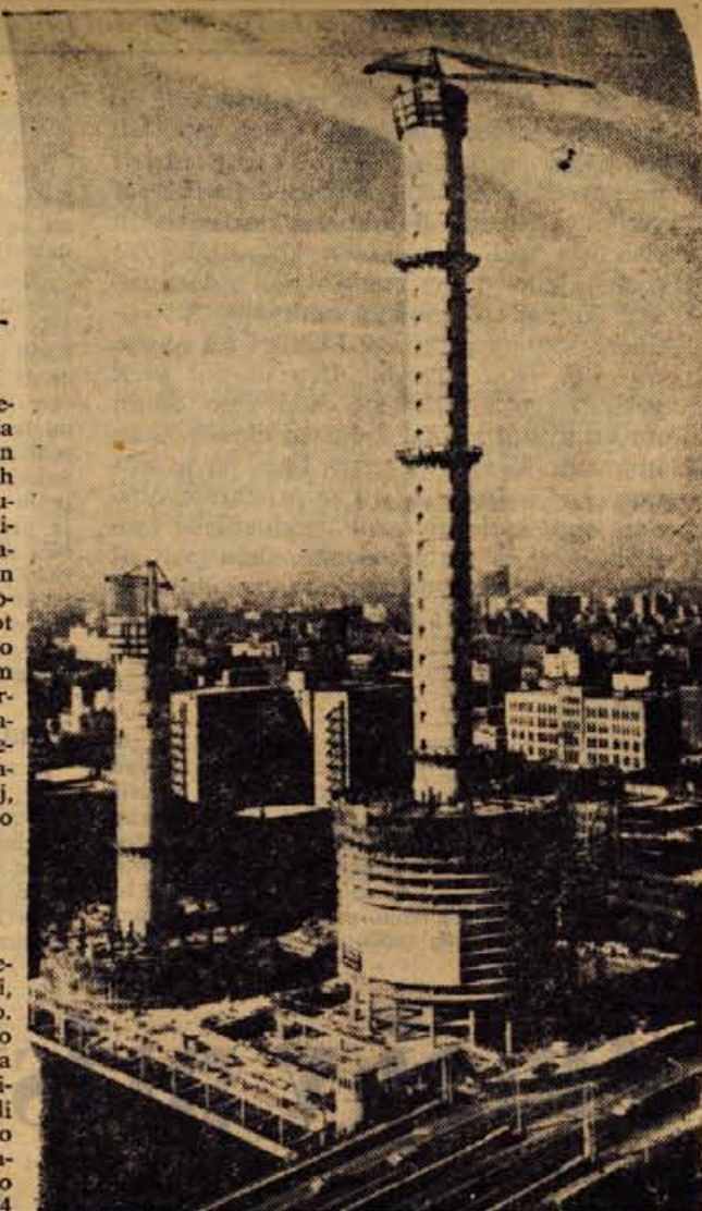
Okrogla 60-nadstropna nebotičnika, ki ju gradijo v Chicagu, hitro raste. — Na sliki je dobro viden okrogel jašek, po katerem bodo hiteila dvigala. Okoli njega nastane vsak drugi dan novo nadstropje. Levo spodaj pod obema nebotičnikoma gradijo pristanišče za 700 čolnov in umetno drsališče
